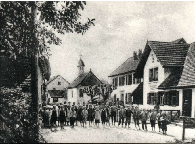
Die alte Schule im Oberdorf wird heute als Gemeindehaus genutzt. Daneben die 2. Kapelle (1820-1928)
